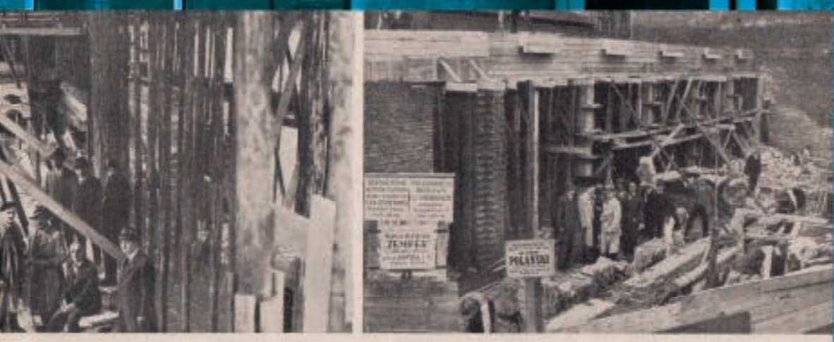
FRAGMENTY BUDOWY DOMU ARTYSTÓW PLASTYKÓW W KRAKOWIE PRZY ULICY ŁORZOWSKIEJ
